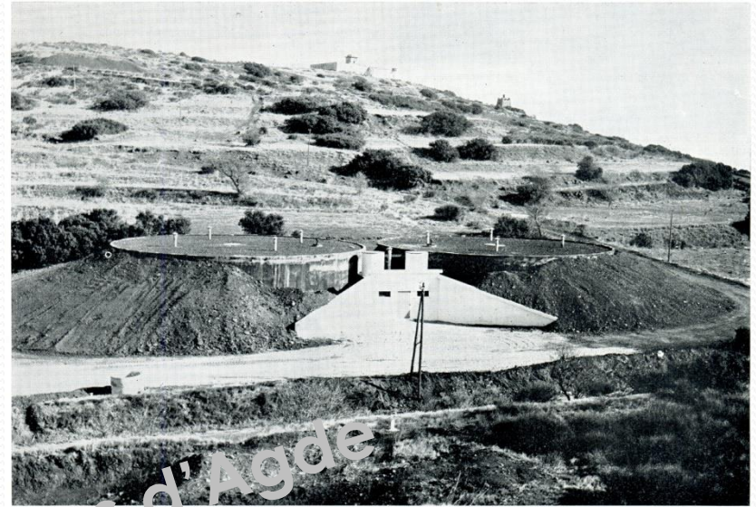
LES L'ESERVOIR ENVERRES DU MONT SAINT-LOU
