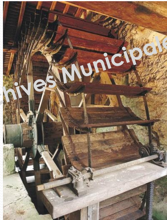
Roue hydraulique verticale pour monter l'eau
