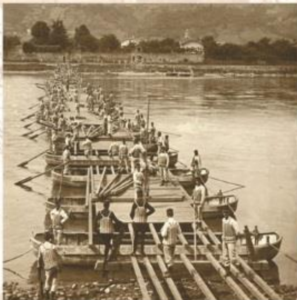
Démontage d'un pont de bateaux
