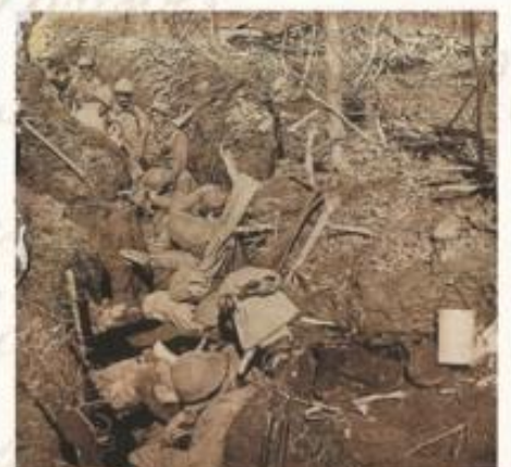
Repos dans une tranchée
