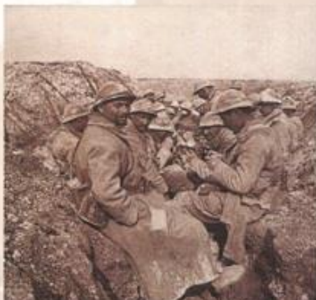
Pause dans une tranchée
