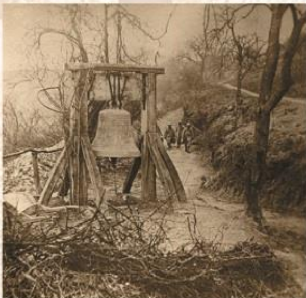
Craonne - Cloche de Vassogne Signal pour les gaz
