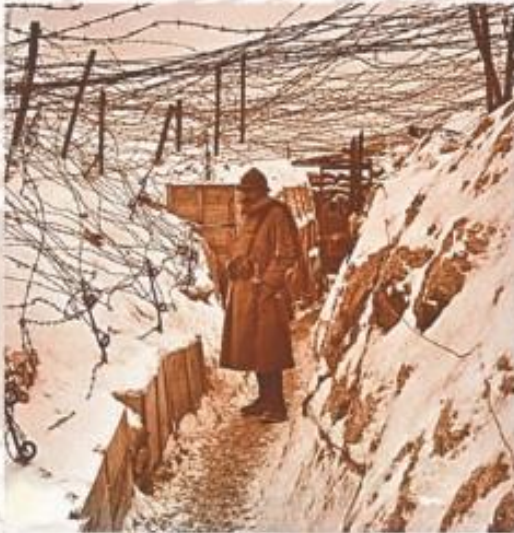
Tranchée sous la neige
