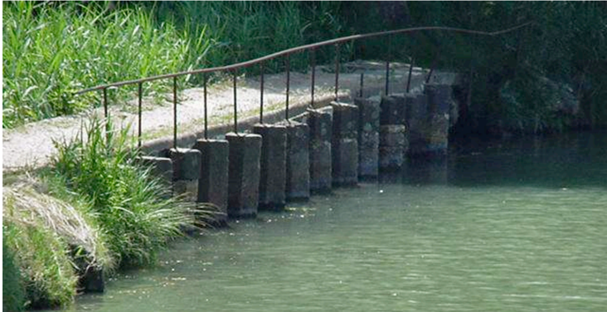
Exemple d'ouvrage alimentant les ruisseaux situés "en aval"
