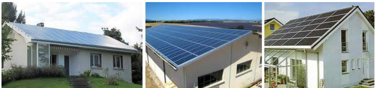
la pose de panneaux sur un pan complet de toiture permet une meilleure intégration, la trame des panneaux est plus ou moins discrète
