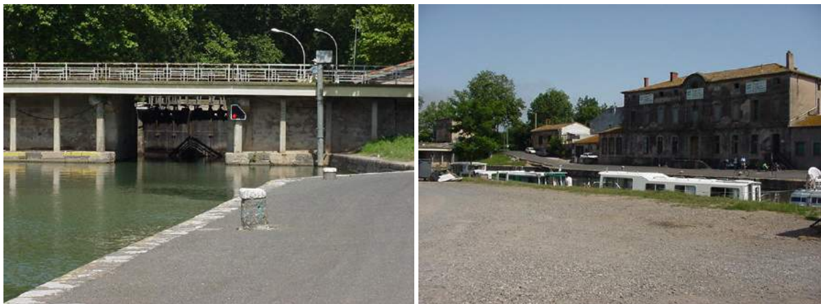
à gauche, l'accès à l'écluse ; à droite la Maison de l'écluse
