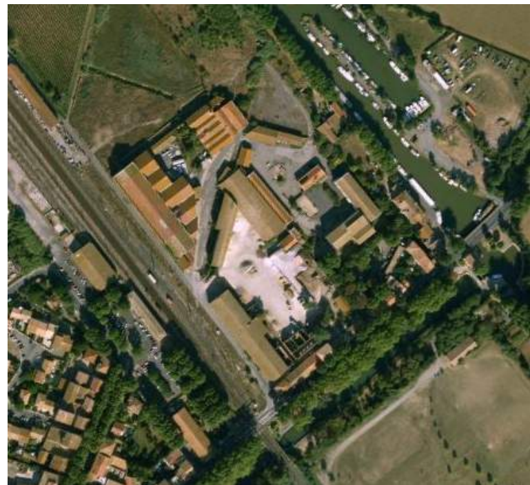
Vue aérienne du site industriel de La Méditerranéenne
