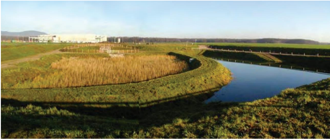
FILTRES PLANTES, AVEC BASSIN PAYSAGE EN SORTIE ; DAMBACH LA VILLE (BAS-RHIN), ZONE D'ACTIVITE
