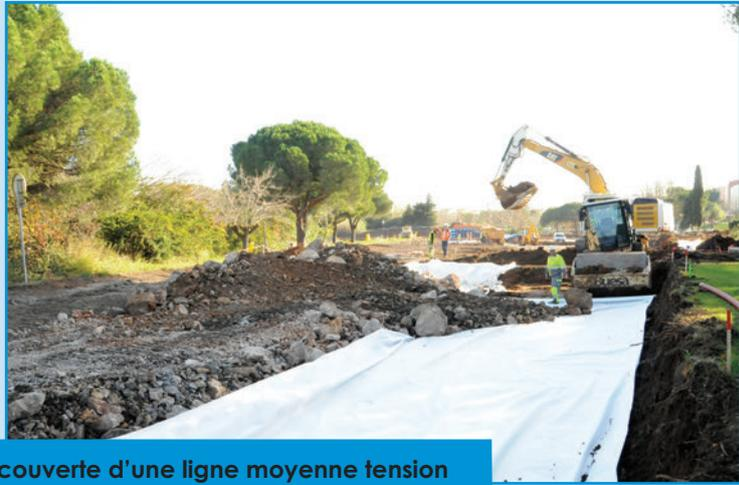
Découverte d'une ligne moyenne tension et pose d'une sous-couche de stabilisation
