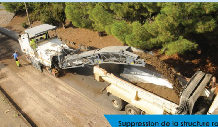
Suppression de la structure routière, récupérée en vue de son retraitement, et démontage des panneaux indicateurs
