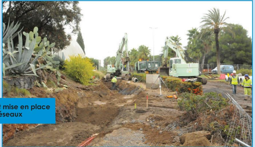
Creusement des tranchées et mise en place des premiers tronçons des réseaux
