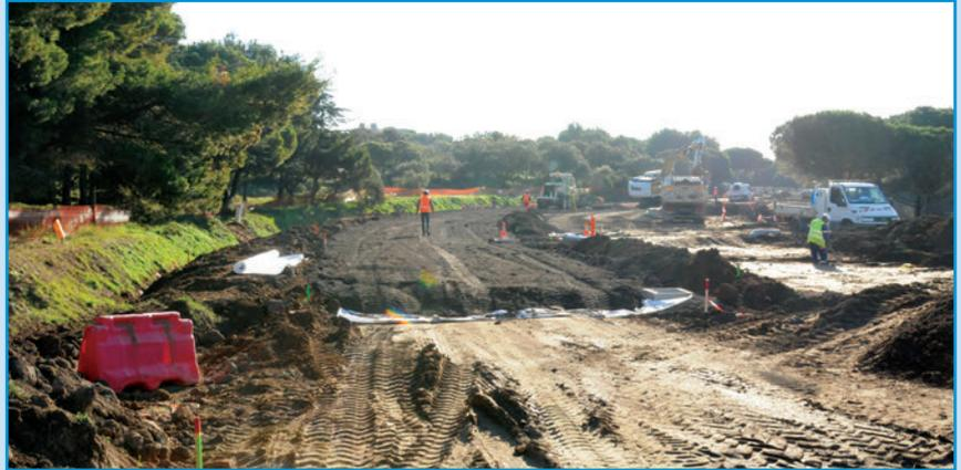
Découverte de roches basaltiques, qu'il faut casser pour installer les réseaux. Ci-dessus, pose des couches stabilisantes. Ci-dessous, le pluvial en attente d'être enterré côté CIT
