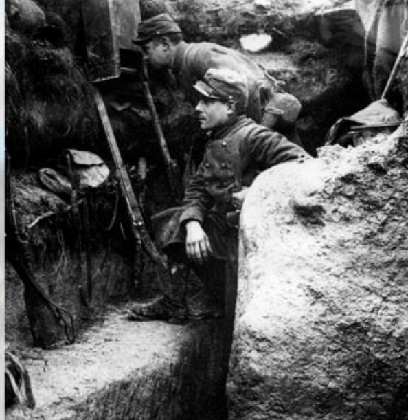
Dans les tranchées
