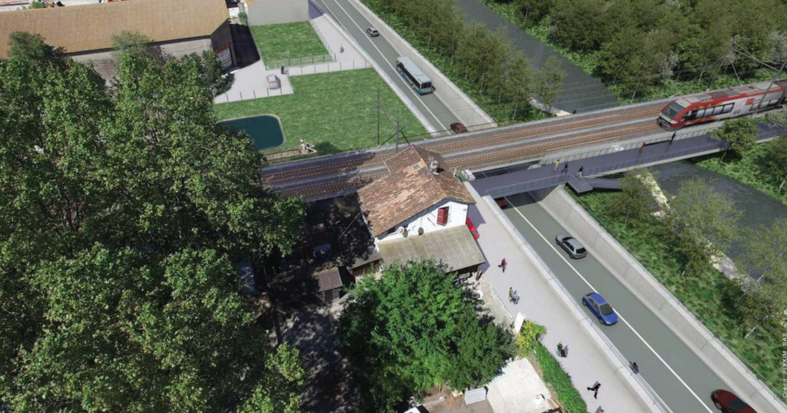
*Le projet comporte 2 voies pour les véhicules, 1 voie pour les vélos côté gare ainsi qu'un passage piétons et PMR (Personnes à Mobilité Réduite) sécurisé, grâce à une passerelle parallèle à la voie ferrée*
