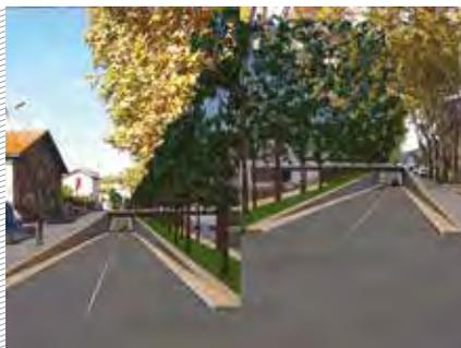
sur **la suppression du passage à niveau** grâce à la création d'**un ouvrage de type Pont-Rail.** Cet aménagement permettra une **requalification significative de l'entrée de ville, des abords et du cheminement le long du Canelet** en lien avec les projets de **la Méditerranéenne, du Port Fluvial, de la villa Laurens et du Pôle d'Échange Multimodal.**
