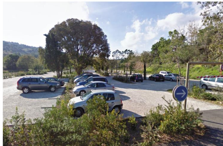
Parking du site classé de l'Anse de Paulilles (66). Grave compacté, bordures semi-enterrées et haies arbustives
