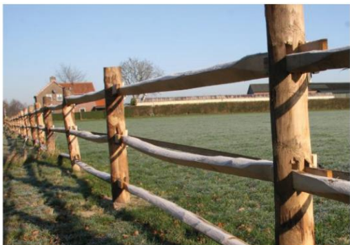
Utilisation du châtaignier écorcé non-traité pour les piquets d'enclos et les barrières équestres
