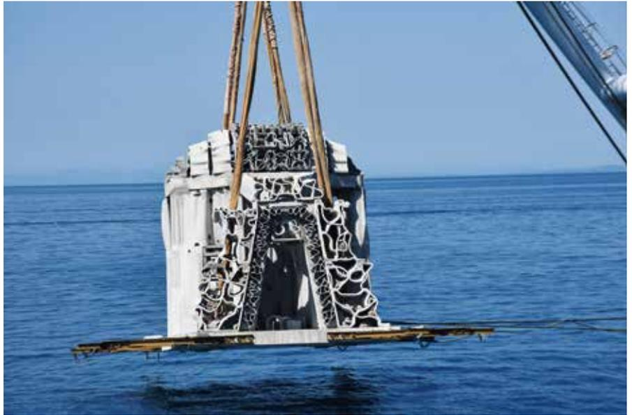
Après l'écoconception des ouvrages intra portuaires du Cap d'Agde du ponton d'accès à l'île de Brescou et du balisage du littoral des 300m avec des modules Xreef 3D servant à la fois de corps-morts et de nurseries, le 4<sup>ème</sup> et dernier lot de ce programme a permis d'installer un village de récifs artificiels 3D au large de l'île de Brescou en juillet 2022.
