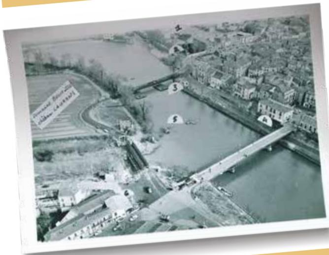
Afin de rétablir la circulation entre les deux rives, trois ponts provisoires furent construits. On retrouve sur cette vue générale ces trois ponts : un sur pilier central face à la cathédrale, un autre sur le canalet et le troisième en face « la Belle Agathoise ». On peut voir entre les deux ouvrages en amont du pont dont la démolition a commencé les deux anciens piliers du pont du Moyen Âge (repère 5) et la dernière partie du Palais des Evêques qui sera démolie. (repère 4)
