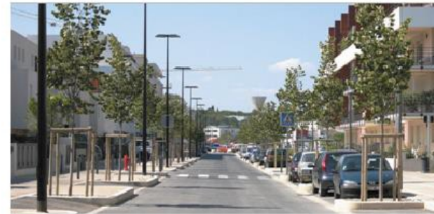
Voie de desserte principale - Malbosc Montpellier
