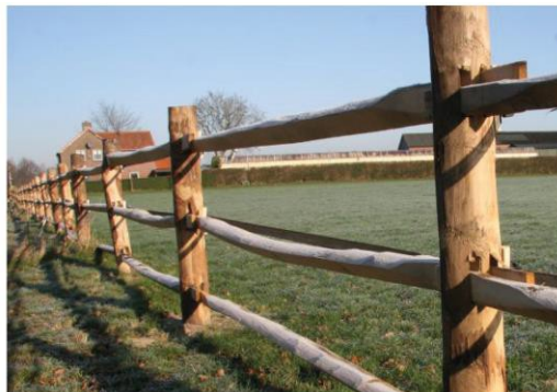
Utilisation du châtaignier écorcé non-traité pour les piquets d'enclos et les barrières équestres
