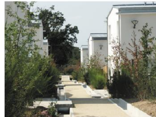
Desserte piétonne - ZAC de la Morinais - 35
