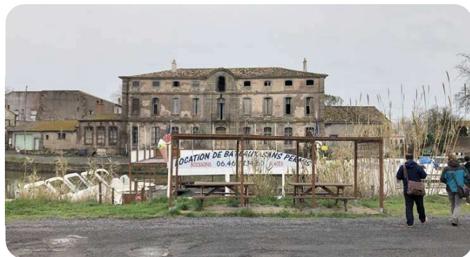
L'hôtel Riquet, un bâtiment repère en état de dégradation
