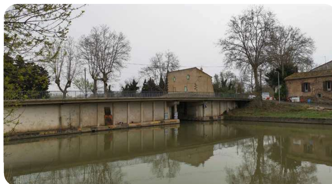
Bassin de retournement
