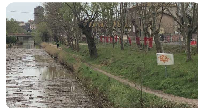
Le chemin du halage du Canalet peu confortable et peu praticable
