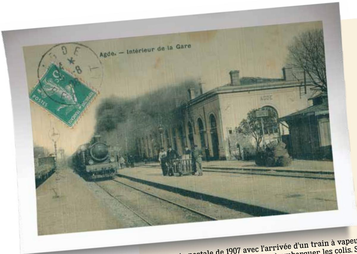
Une carte postale de 1907 avec l'arrivée d'un train à vapeur venant de Sète et les bagagistes sur le quai prêts à embarquer les colis. Sur la gauche, la pompe à eau et son grand réservoir en tôle noire servant à alimenter les machines à vapeur avec l'eau pompée dans l'Hérault par une grosse conduite longeant le château Laurens.
