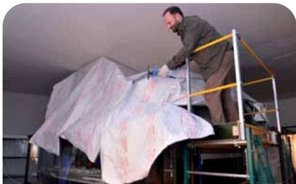
Soudure des différents voiles avant la mise sous vide
