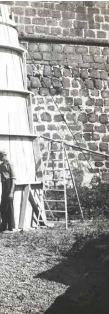
#Photo n°5 1934 : construction par l'entreprise « Victor Guibal » d'une balise en béton pour signaler le récif de la Lauze entre la jetée Richelieu et le Fort. Le moule en bois ferrailé fut construit sur la petite plage au pied du Fort.
