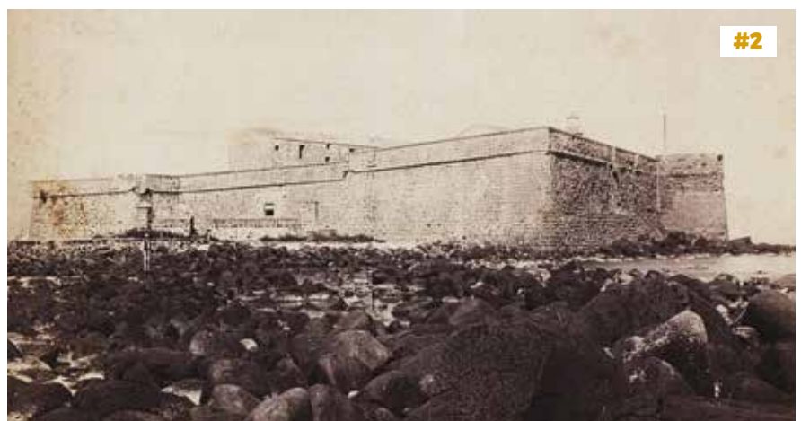
#Photo n°2 Une des plus anciennes photos du Fort datant de 1890 nous montre les nombreux rochers qui, aujourd'hui, sont sous l'eau.
