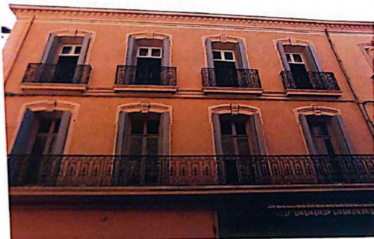
Photo 5. Menuiseries extérieures en cours de restauration à l'ancienne
