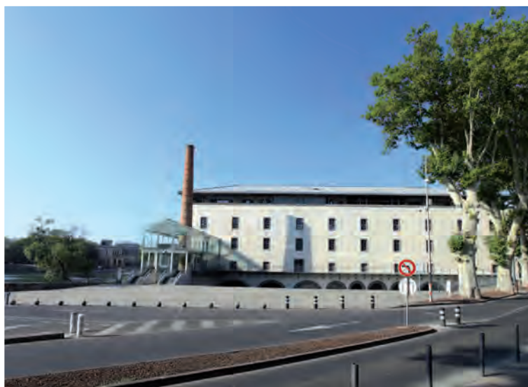
La réhabilitation du Moulin des Evêques : une restructuration d'ensemble
